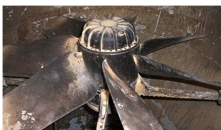
Tilsmudset ventilator.
