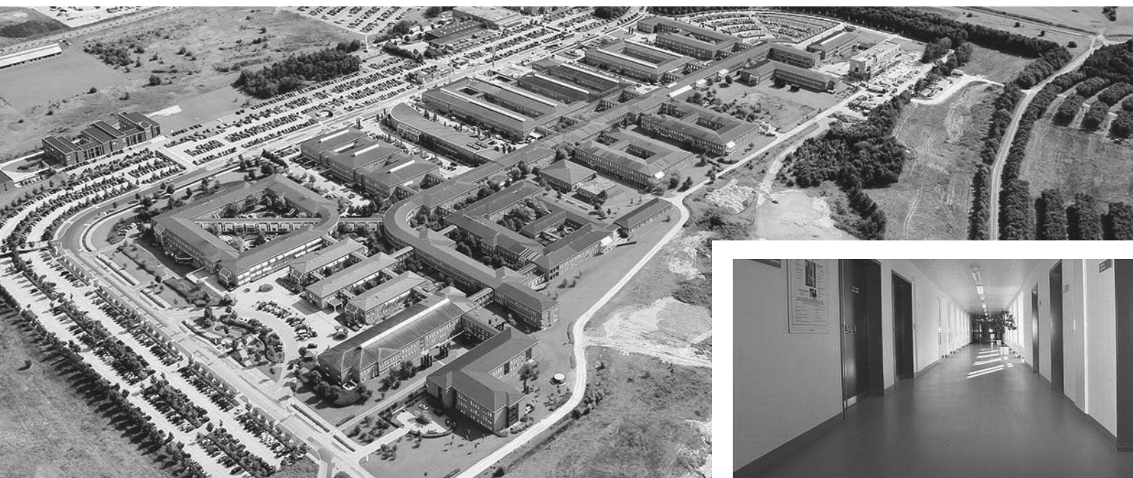
Skejby Hospital anlægges som et gadehospital. Gaderne forbinder de enkelte enheder, som ligger vidt spredt fra hinanden. Omend med betydelig tættere afstand imellem bygningerne end pavillonbyggeriet - og med mekanisk ventilering som indbygget standard
