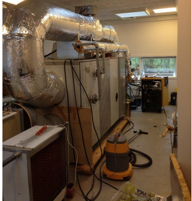
Figur 5.1 a) Billede af Kaeser kompressoraggregatet samt varmeafgiver- og olieseperationssystem. b) Billede der viser sammenkoblingen af varmeafgiveren og dampkredsen i affugteren.
