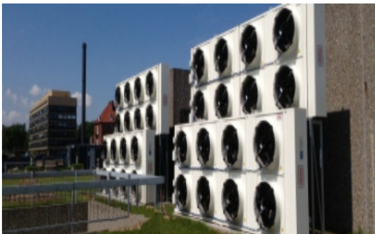
Figur 23 Tørkøler med horisontalt afkast
