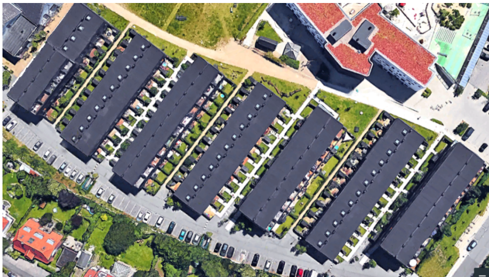
Figur 4-1 Boligafdelingen Grøndalsvænge under AKB København var den første boligafdeling, der fik beregnet et hybridanlæg, men den praktiske gennemførelse blev stoppet, da DONG Energy Distribution (i dag Radius Elnet) forlangte, at anlægget blev splittet op i 7 særskilte anlæg.
