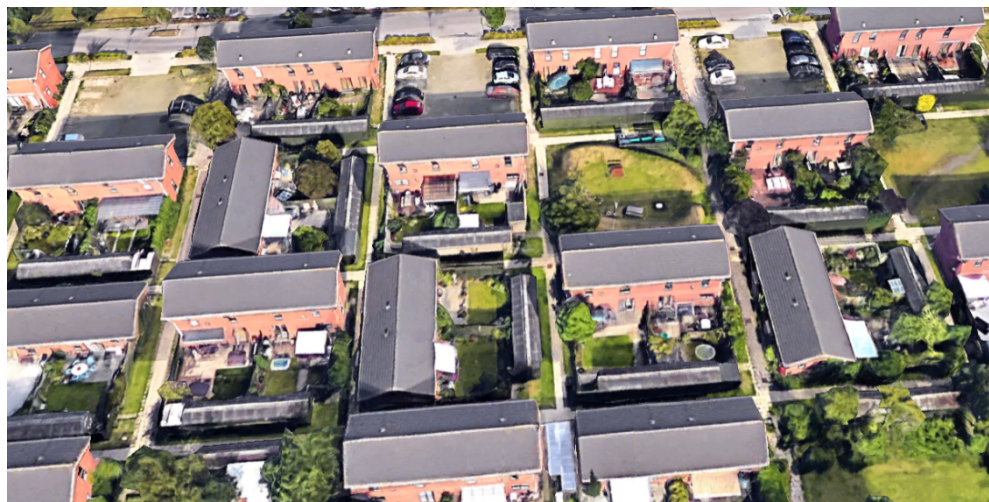
Figur 3-5 Boligafdelingen Rødtjørnen afd. 5 i Dragør, der hører under Boligselskabet Strandparken, er en af de almene boligafdelinger, der har fået bevilget ydelsesstøtte til at installere et hybridanlæg med 258 kWp solceller og et batterilager på 129 kWh.
