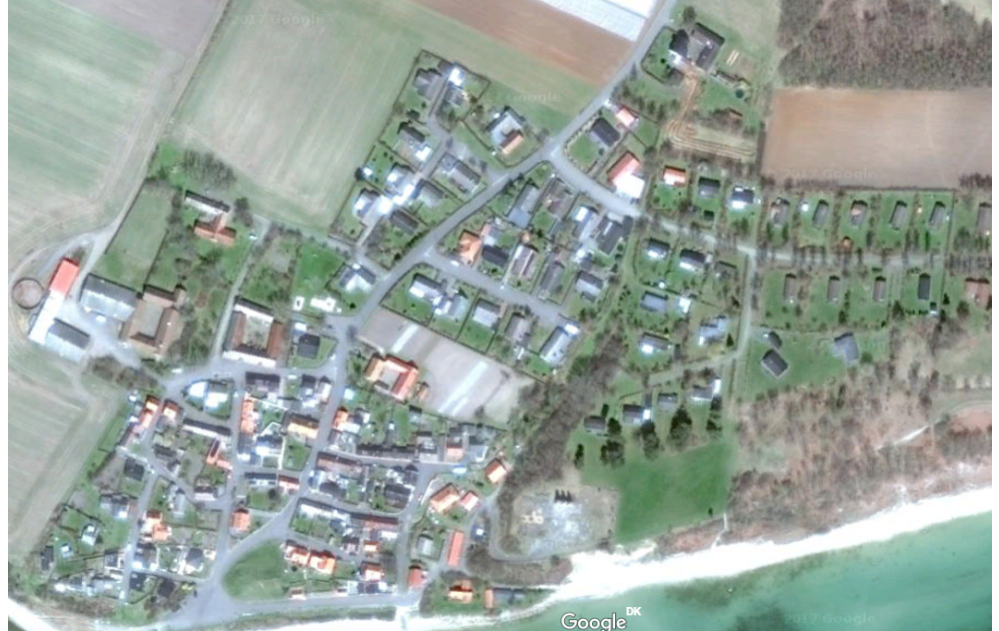
Figur 8-4 I en ansøgning til EUDP-programmet er landsbyen Arnager, der er nabo til Bornholms Lufthavn, udset til at danne rammen om en konvertering fra oliefyrd til solenergi og el. Luftfoto fra Google Earth
