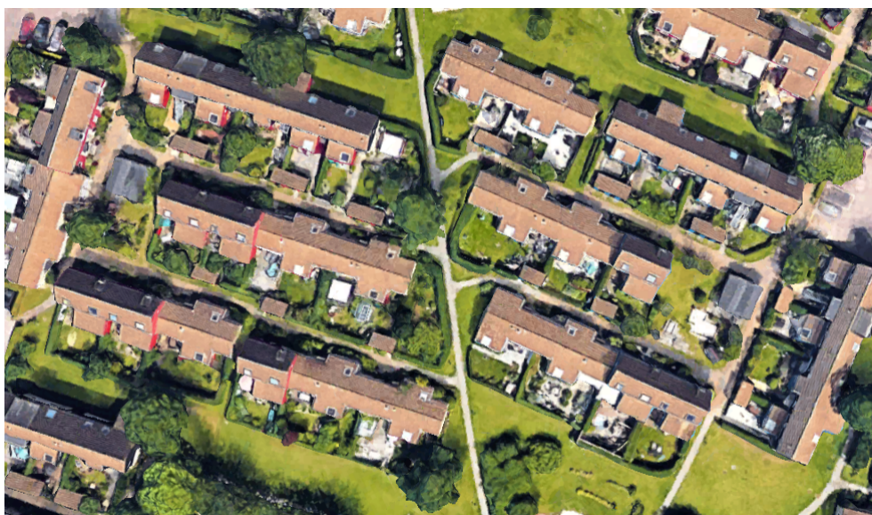
Figur 8-15 Som en tæt/lav bebyggelse har Hedelyngen samlet forholdsvis store tagflader, og det kan derfor kun betale sig at installere solceller på en del af tagarealet. Resten af det nye tag kan udstyres med billigere "dummy"-tagplader, der ligner solcellerne, men ikke producerer el. Luftfoto fra Google Earth
