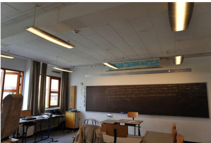
Fig 6 (a) I et klasselokale på Hotherskolen er implementeret LED belysning som drives af solceller på skolens tag. Armaturet til LED belysningen er udviklet af Kent Laursen. (b) Karakterisering af lyset af LED systemet. Det ses at farvetemperaturen er 2920 K og Ra indekset er 85
