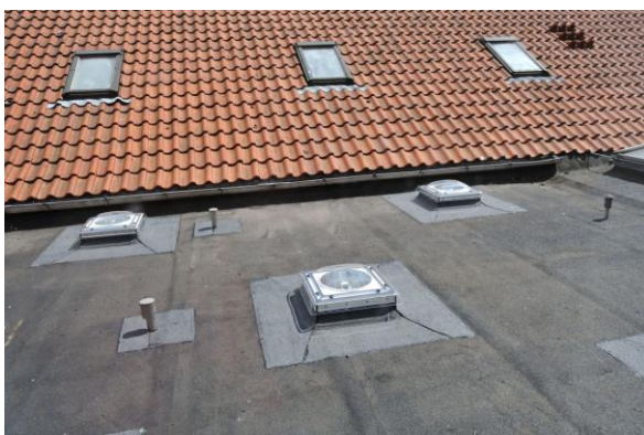
Figur 8.(a) Ovenlysvindue hvor sollyset kobles ind i lystunellen. (b) Lys målt i lumen som typisk sendes ind igennem lysskakten
