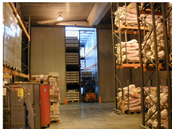
Figur 4.5. Lager hos Frigoscandia. Bagerst er en indfrysningstunnel. Begge steder blæsere omfattet af afbrydelighed.
