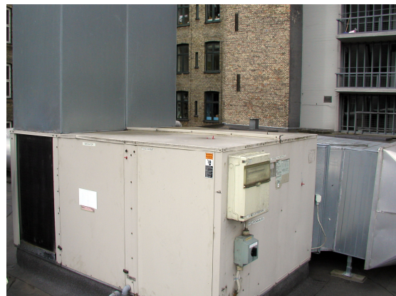
Figur 4.7. Ventilationsanlæg med indbygget varmepumpe, der kan afbrydes af Elkraft System.
