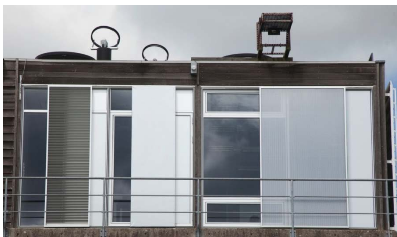
Figur 9. Foto af Energy Frames elementerne monteret på Dagslyslaboratoriet, her med de bevægelige rammer i halvt åbne positioner.
