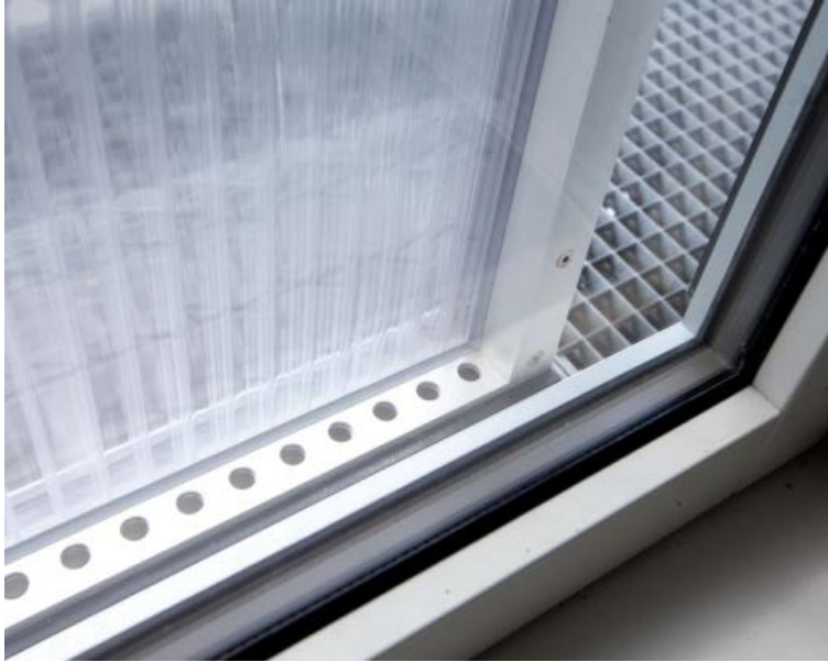
Figur 14. Energy Frames ventilationselementet med forskydelige hulprofiler indbygget foroven og forneden, således at åbningerne kan reguleres.
