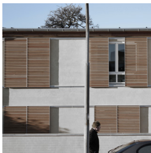
Figur 2. Manuelt bevægelige teakrammer med drejelige lameller på privat bolig.
