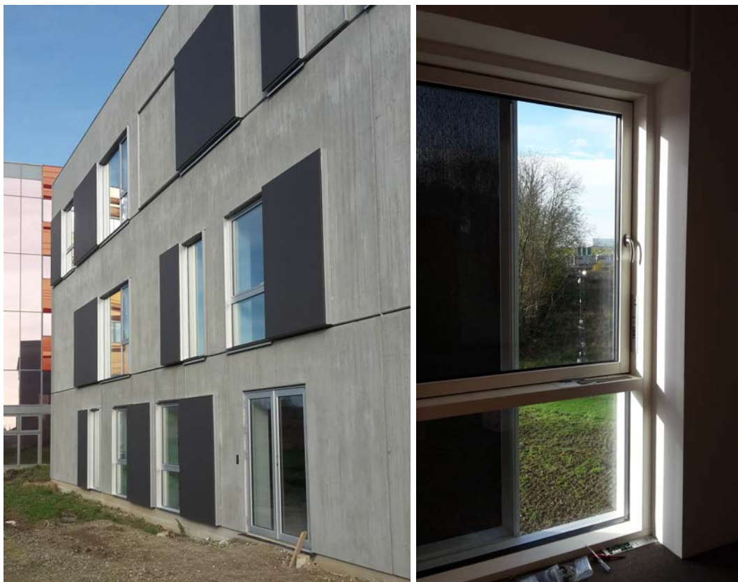
Figur 52. Fotos af sydvestfacaden i Green Tech Lab bygningen kort efter den officielle indvielse i oktober 2014. Til højre set indefra et af lab-kontorerne i stueetagen med Energy Frames elementet kørt halvt for vinduet.
