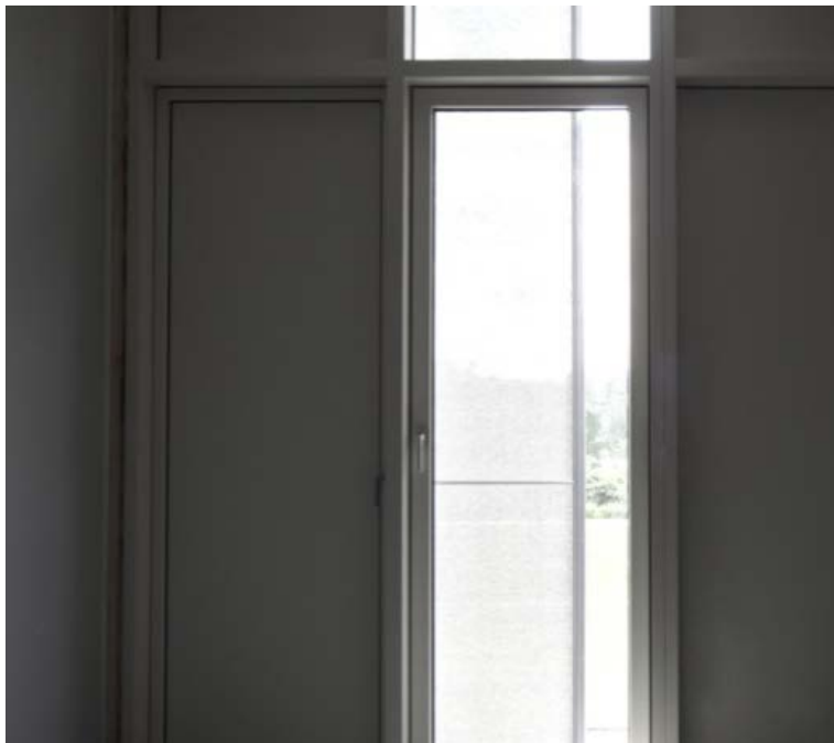
Figur 10. Energy Frames element med lys screendug, som diffuserer det lys der passerer, hvorved udsynet næsten blokeres helt.
