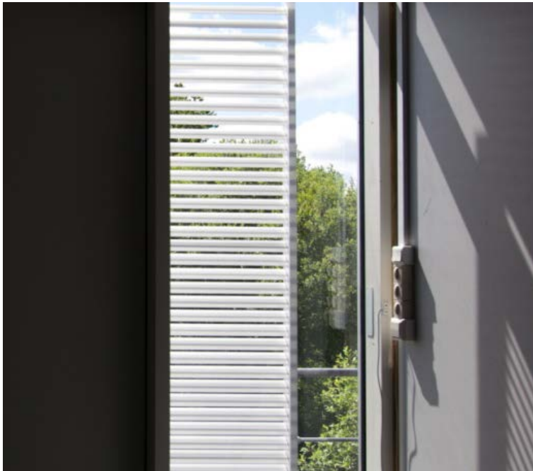
Figur 11. Energy Frames element med indbygget lamelafskærmning (persienne).
