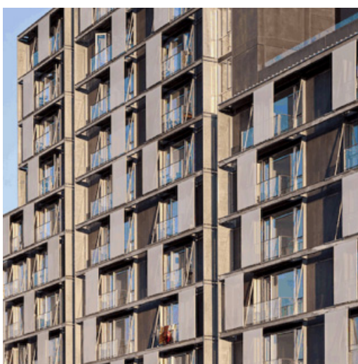
Figur 1. Manuelt bevægelige tekstilrammer som solafskærmning på altanen i almenyttige etageboliger Sejllhuset.
