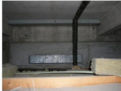
Rist i Gangloftrum/udsugningskanal
