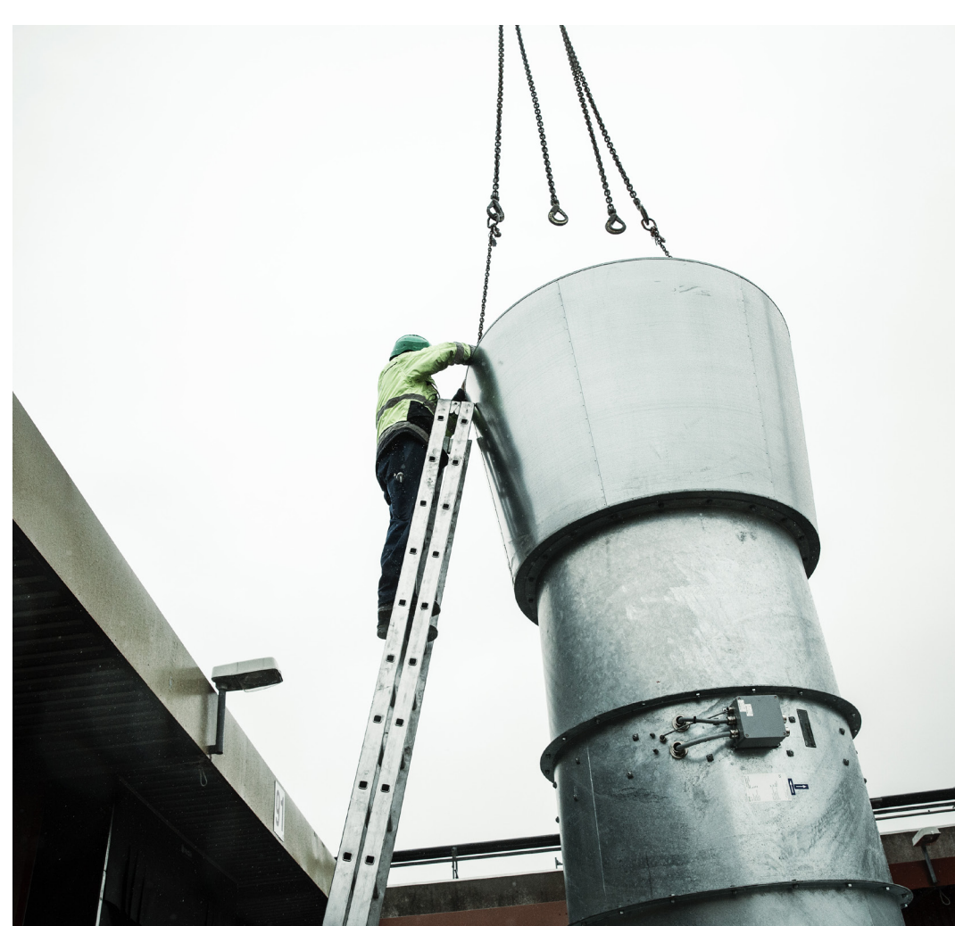
Lyddæmper, diffuser og ventilator under montage - med lyddæmper øverst.
