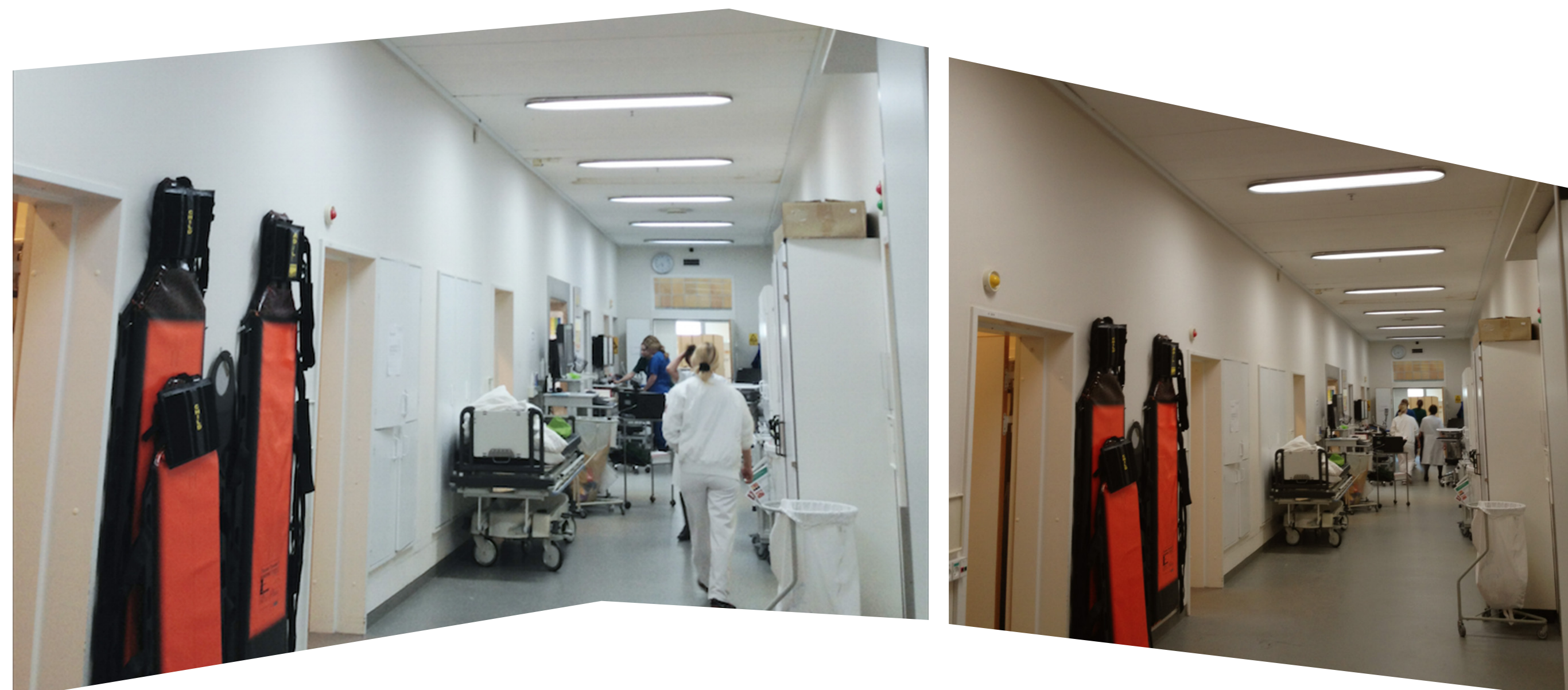
LED-armaturet til Slagelse Sygehus kan varieres i farvetemperatur for bedre at kunne efterligne dagslysets døgnrytme. Til venstre en koldere temperatur med høj Kelvin-værdi, til højre en mere varm hvid temperatur.
