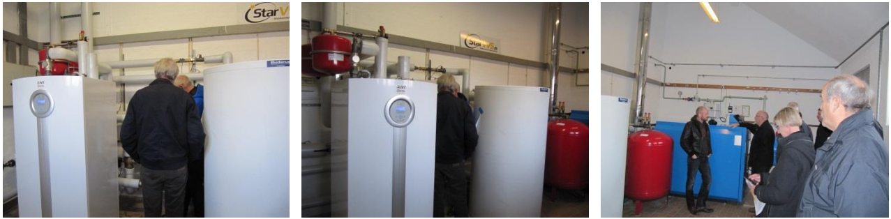
Billede 3, 4 og 5: Besigtigelse af den nye varmecentral
