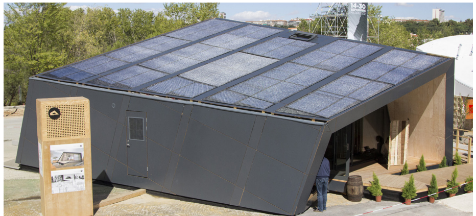
Fold Huset er konstrueret, så det giver den bedst mulige placering for solceller på taget og med de største vinduer mod nord med en 19 graders drejning mod vest.
