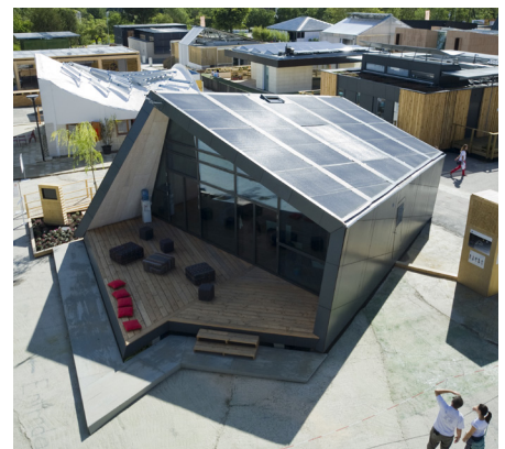
Undervejs blev forskellige køle- og opvarmningsstrategier testet, og det termiske indeklime blev målt. De store vinduer betød, at huset ikke i første omgang levede op til energimålet.
