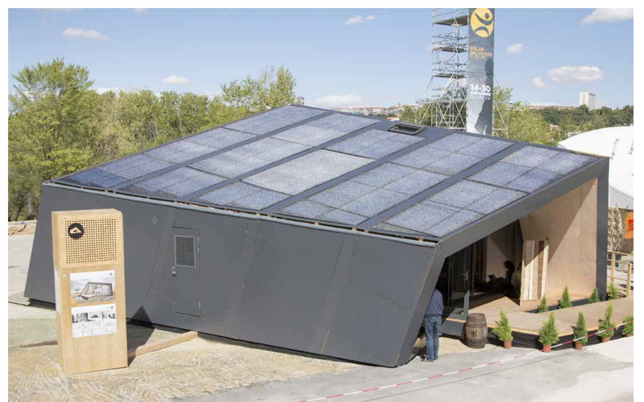
Huset er konstrueret, så det er optimalt for placering af solceller på taget.
