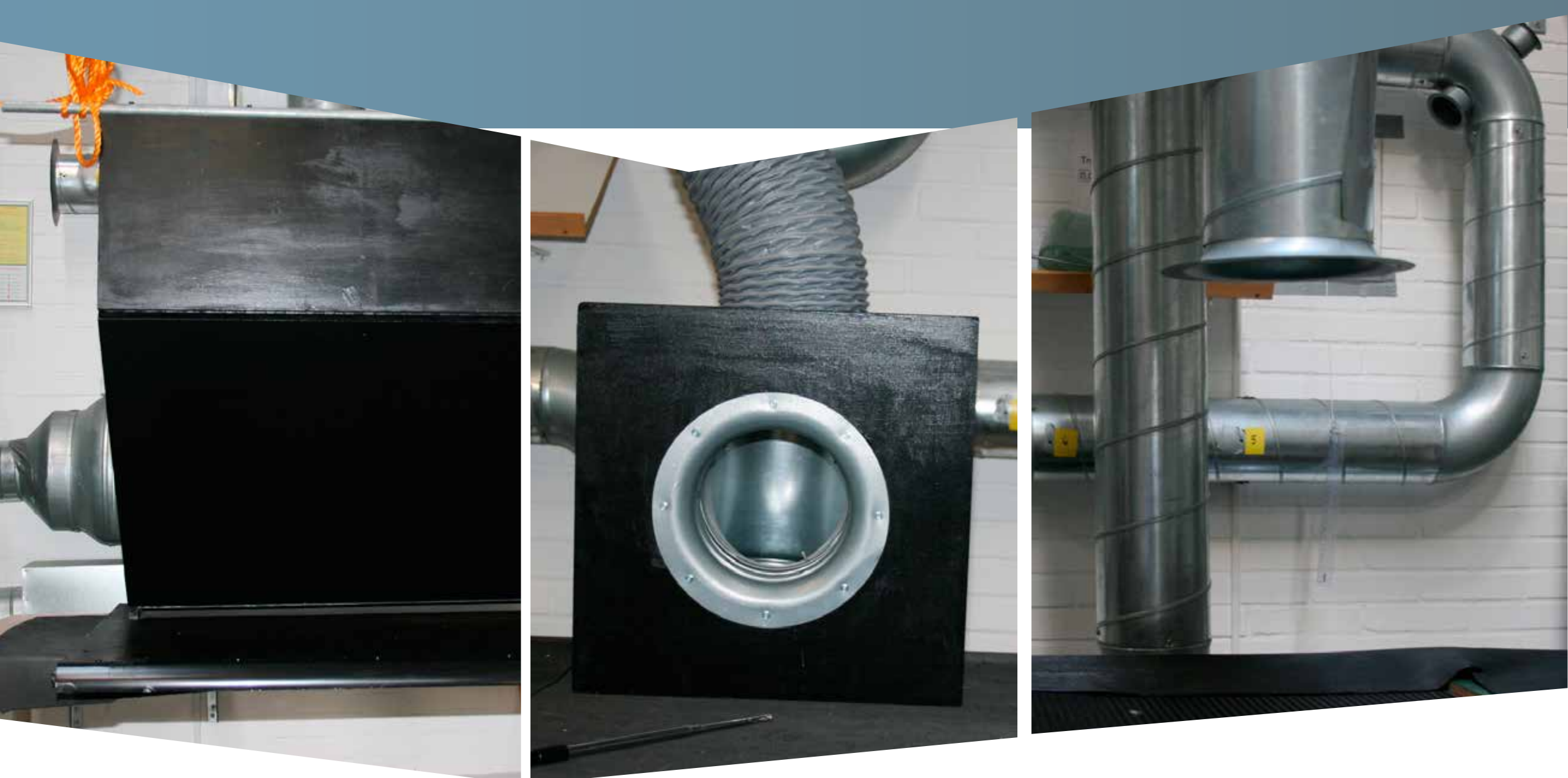
Eksempler på 3 forskellige udsugningsløsninger. Fra venstre, udsugningseffektivitet på henholdsvis 1,0 - 0,5 - 0,25.
