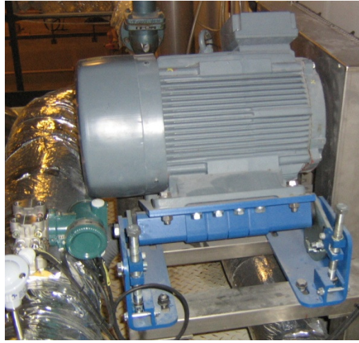
Figur 5. Eldrev med variabelt omløbstal: til venstre frekvensstyring og til højre traditionel elmotor.
