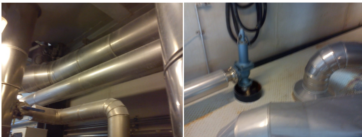
Figur 30. Til venstre: Øverst i billedet ses ejektorens diffusor og afgrening op gennem dækket til tryksikringsventil. Til højre: Tryksikringsventilen set oppe fra dækket og damptilførselsrør til 1. og 2. trin.
