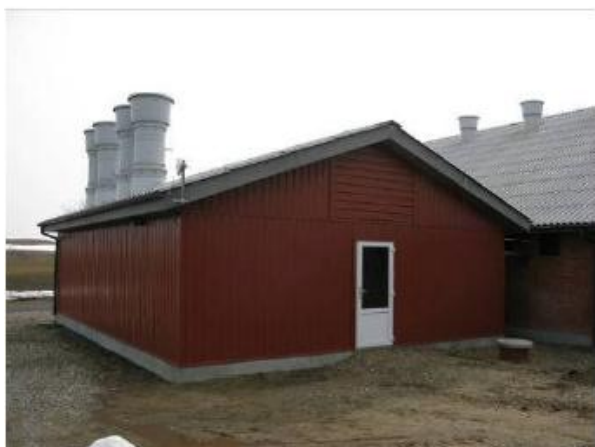
Figur A2. Luftrenseren fra SKOV A/S var placeret i en tilbygning ved siden af slagtesvinestalden.
