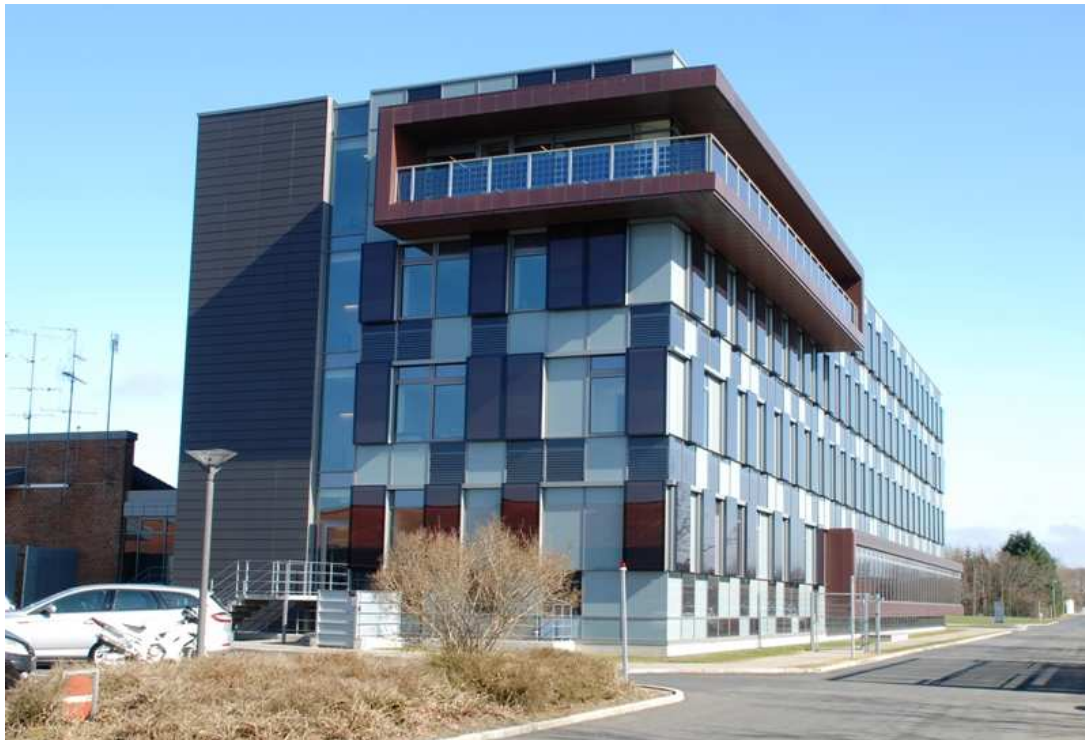
Figur 2.8 Foto af bygningens vest- og syd-facade.
