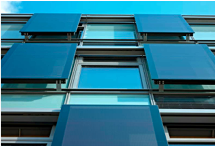
Figur 3.4 Solskoder monteret med tyndfilmsolceller.
