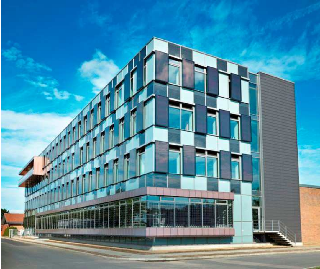
Figur 2.7 Foto af den færdig bygnings øst- og syd-facade.
