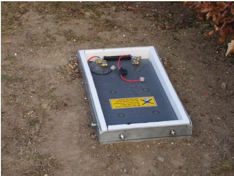
Batterikasse monteret i jorden under lygtemasten
