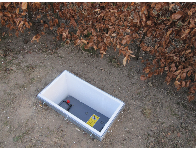
Batterikasse monteret i jorden under lygtemasten
