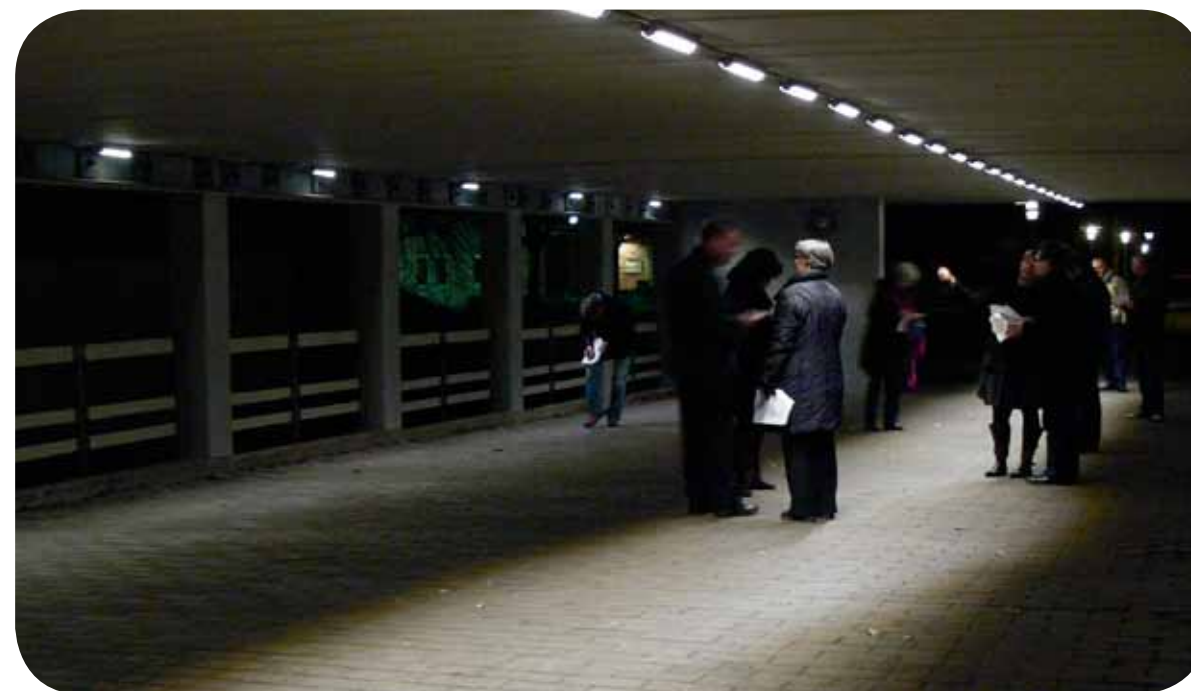
Tunnelbelysning Albertslund. Bemærk lysets skarpe afgrænsning. Foto: Steen Traberg-Borup.
