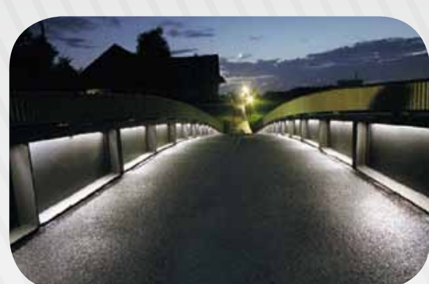
GANGBRO Steinhausen, Schweiz Foto: Osram
