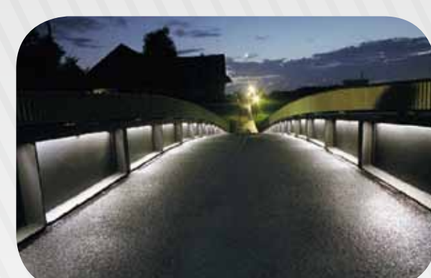
GANGBRO Steinhausen, Schweiz Foto: Osram
