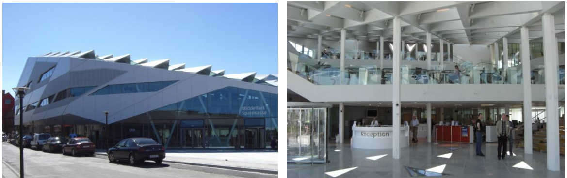
Figur 2 Demonstrationsbygningen Middelbart Sparekasse. Facade mod øst med indgang til banken (billede til venstre). Bankens forhal med kassefunktion / kundeekspedition nederst og åbne plateauer med kontorlandskab øverst (billede til højre)
