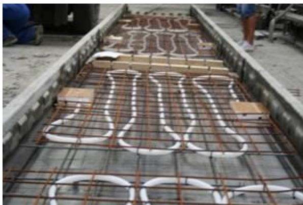
Figur 7 Støbeform for præfabrikerede termodæk klargjort med plastslanger fastgjort til armeringsnet (Spæncom)
