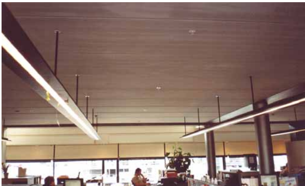
Figur 8.2 Foto af et loft udført med synlige betondæk - LO på Islands brygge
