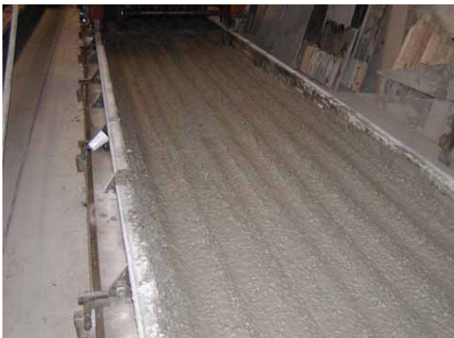
Figur 7.7 Foto fra prøvestøbning - færdigstøbt underbeton
