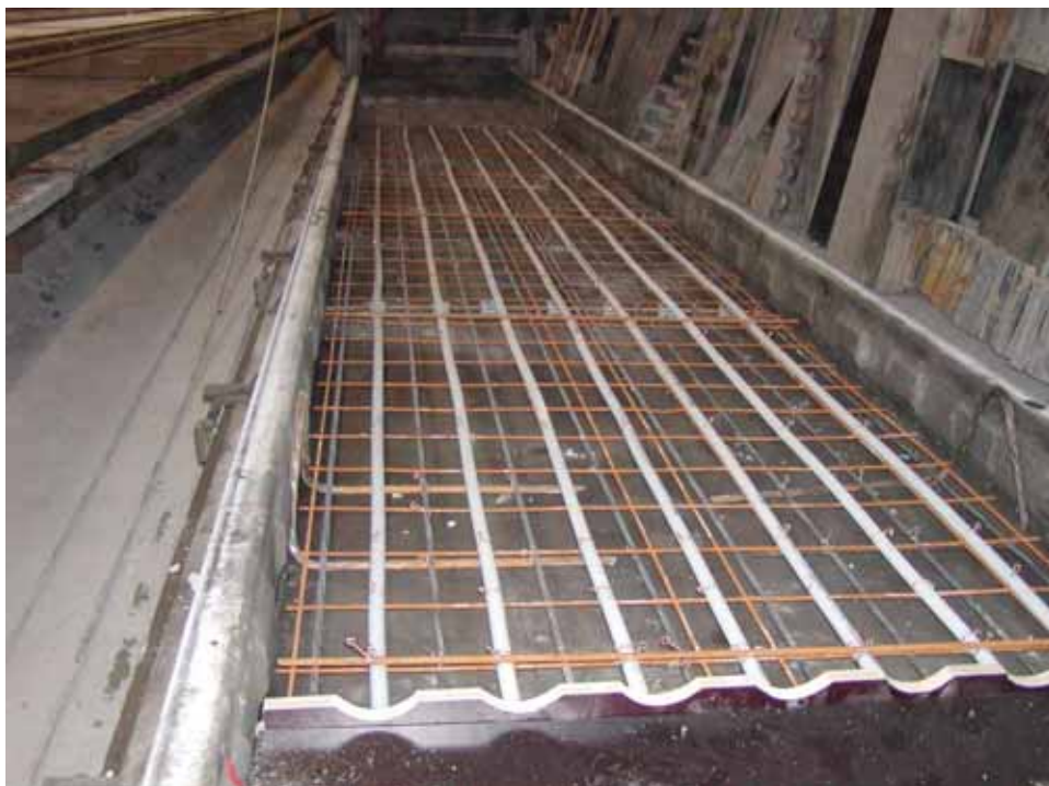
Figur 7.5 Foto fra prøvestøbning - støbeklar form med slanger monteret, der dog stadig kræver en del arbejdstid, som vil kunne nedbringes ved en produktmodningsindsats frem mod et produkt, der er egnet for industriel produktion.
