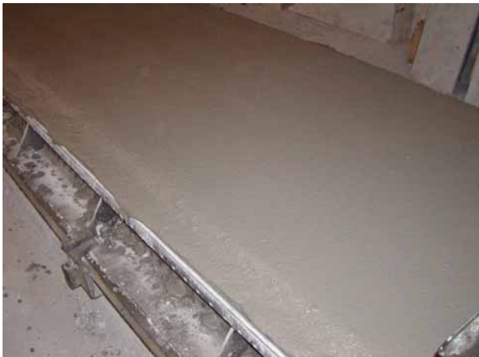
Figur 7.8 Foto fra prøvestøbning - færdigt element
