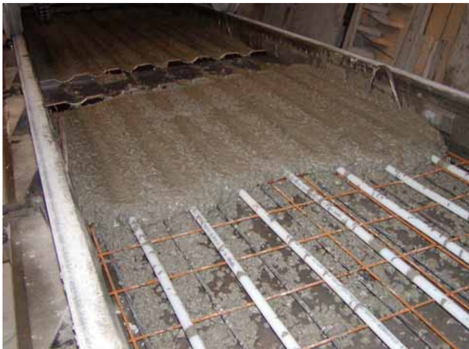
Figur 7.6 Foto fra prøvestøbning - slanger delvist indstøbt i underbeton
