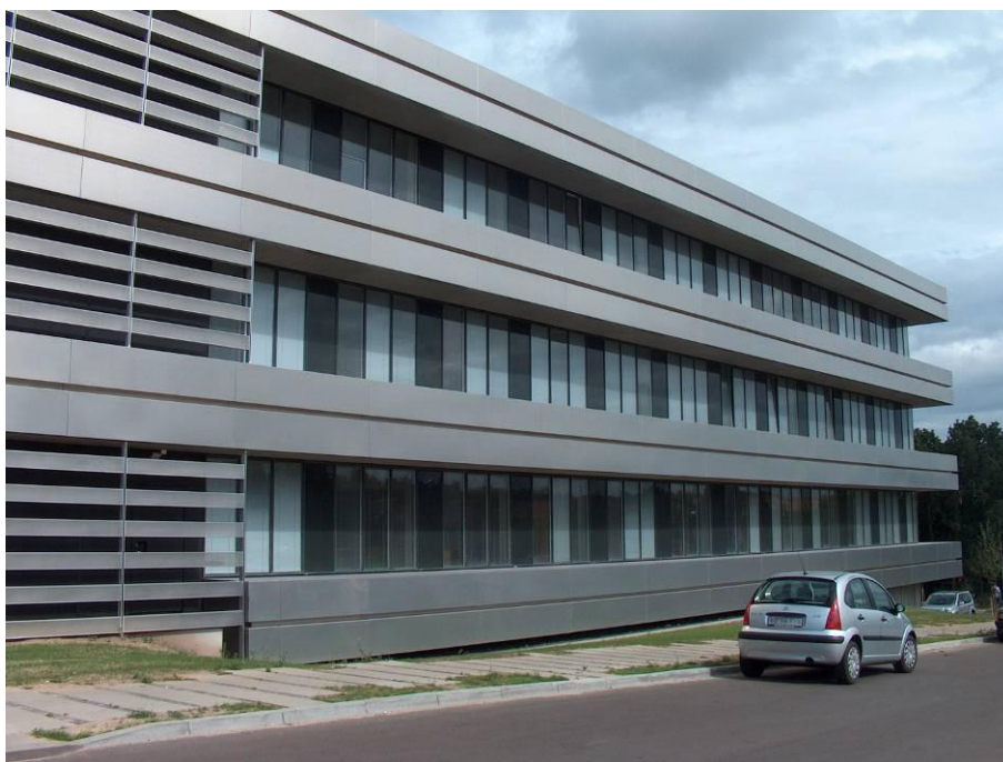
Figur 18. Hovedfacaden imod Skanderborgvej.
