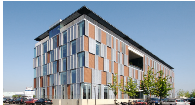
Arkitektonisk spil med begrænsede vinduesarealer FIH-Bank, København
