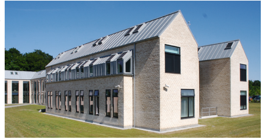
Styret naturlig ventilation i lavenergikontor VKR-Holding, Hørsholm
