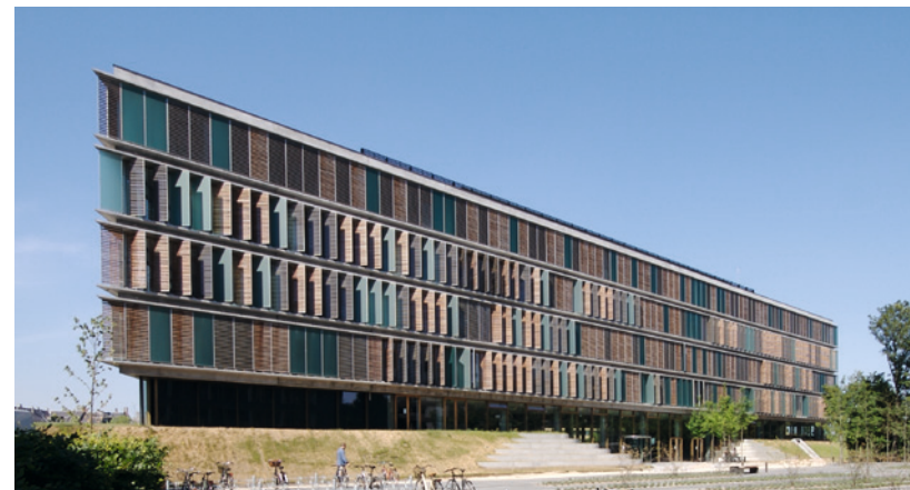
Automatisk solafskærmning til dagslys- og indeklimastyring CBS, Frederiksberg
