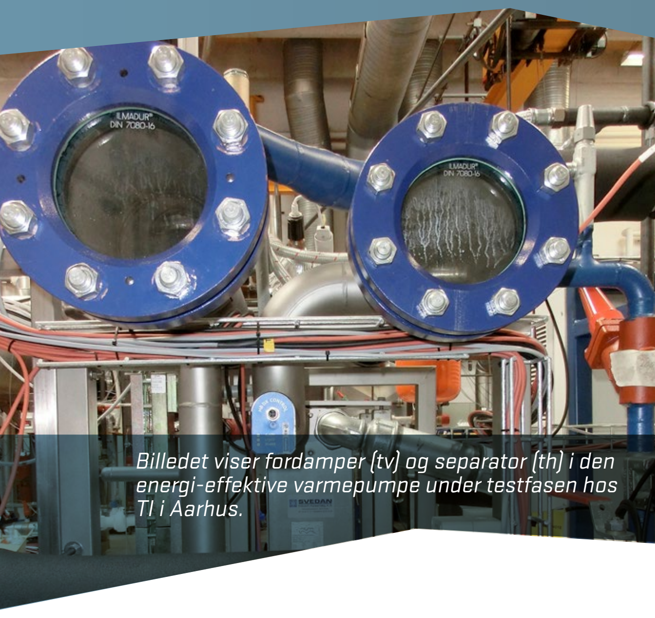
Her ses fordampersiden af varmepumpen. Det er separatorens øverst med fordampere nedenunder, begge leveret af Alfa Laval. Nederst ses kølepumpen, som Grundfos har leveret.
