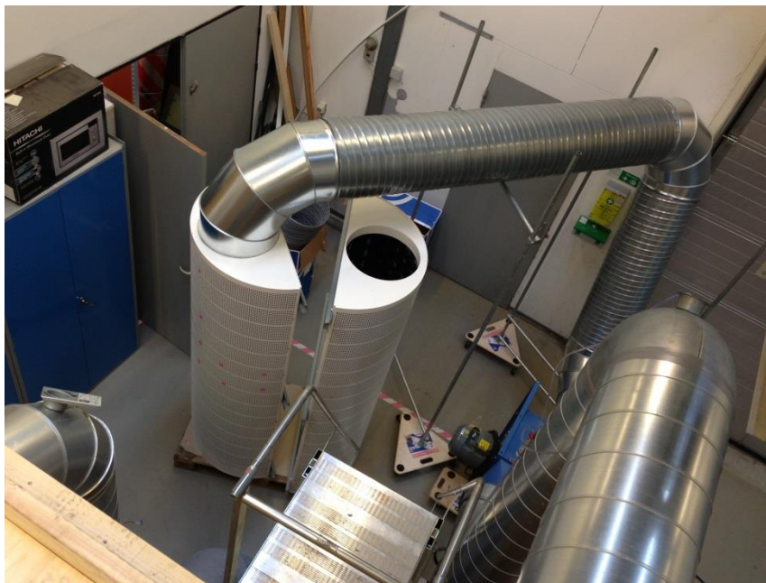
Figur 17.21 - Comdif CBA4020 indblæsningsarmatur.
