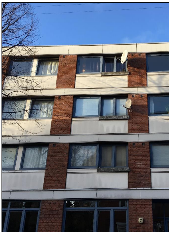
Figur 5. Facaden af Dagmargården, eksempel på etageboliger med betonbrystning
