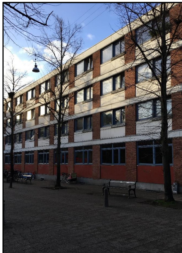
Figur 5. Facaden af Dagmargården, eksempel på etageboliger med betonbrystning
