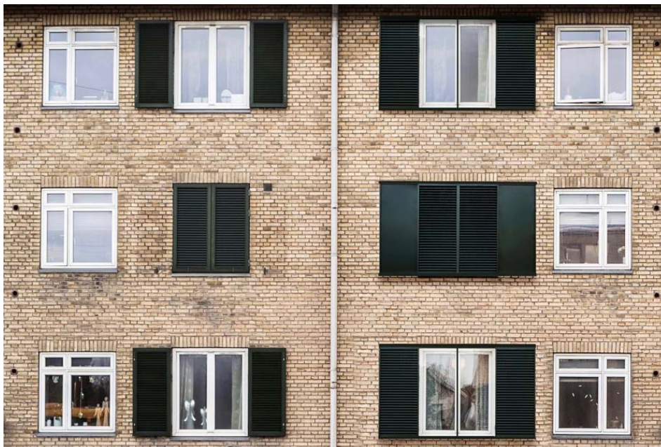
Figur 29. Foto af Folehaven med eksisterende, almindelige skodder(t.v.) og nye lydskodder (t.h.).
