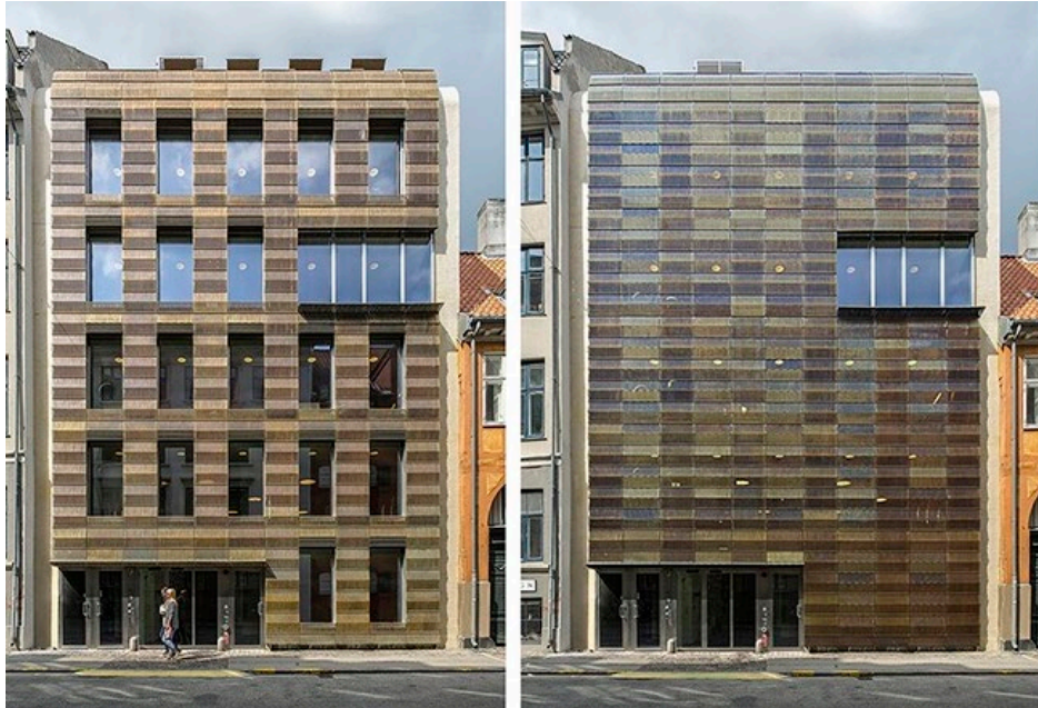
Figur 3. Hovedsæde for smykkeforretning i Toldbodgade. Her er anvendt vandrette foldeelementer, der elegant kan åbne for individuelle vinduespartier, og lukke bygningen af om natten. Foto: Art Andersen.
