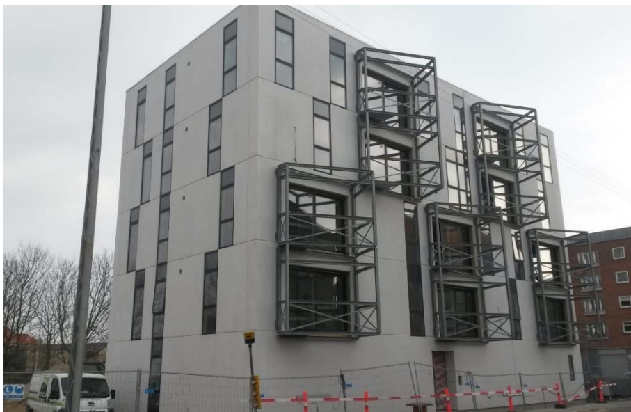
Figur 3.9 Altanerne er opbygget af et metalskelet monteret udvendigt på vægelementerne.
