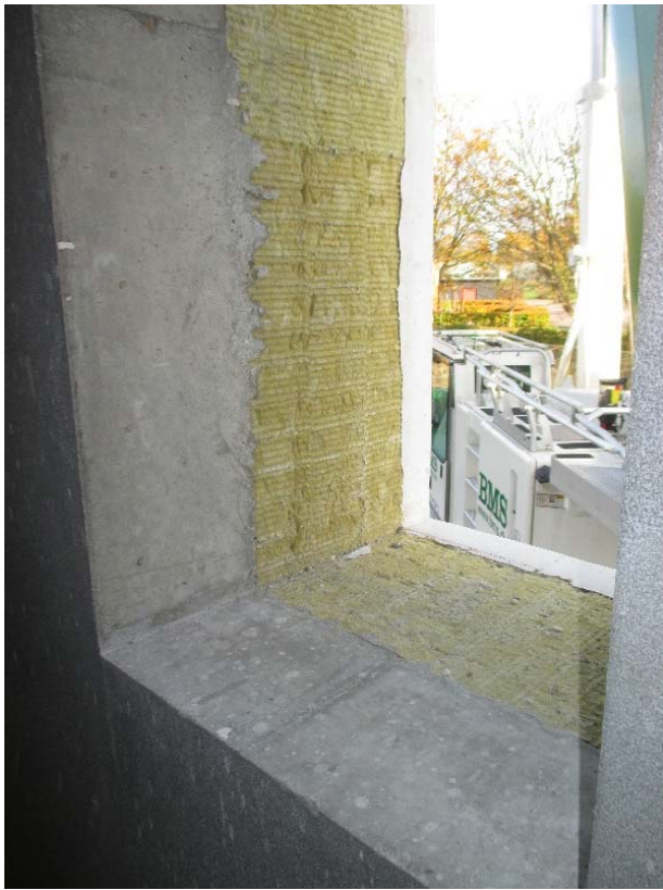
Figur 3.6 Vinduesåbning i et vægelement.
