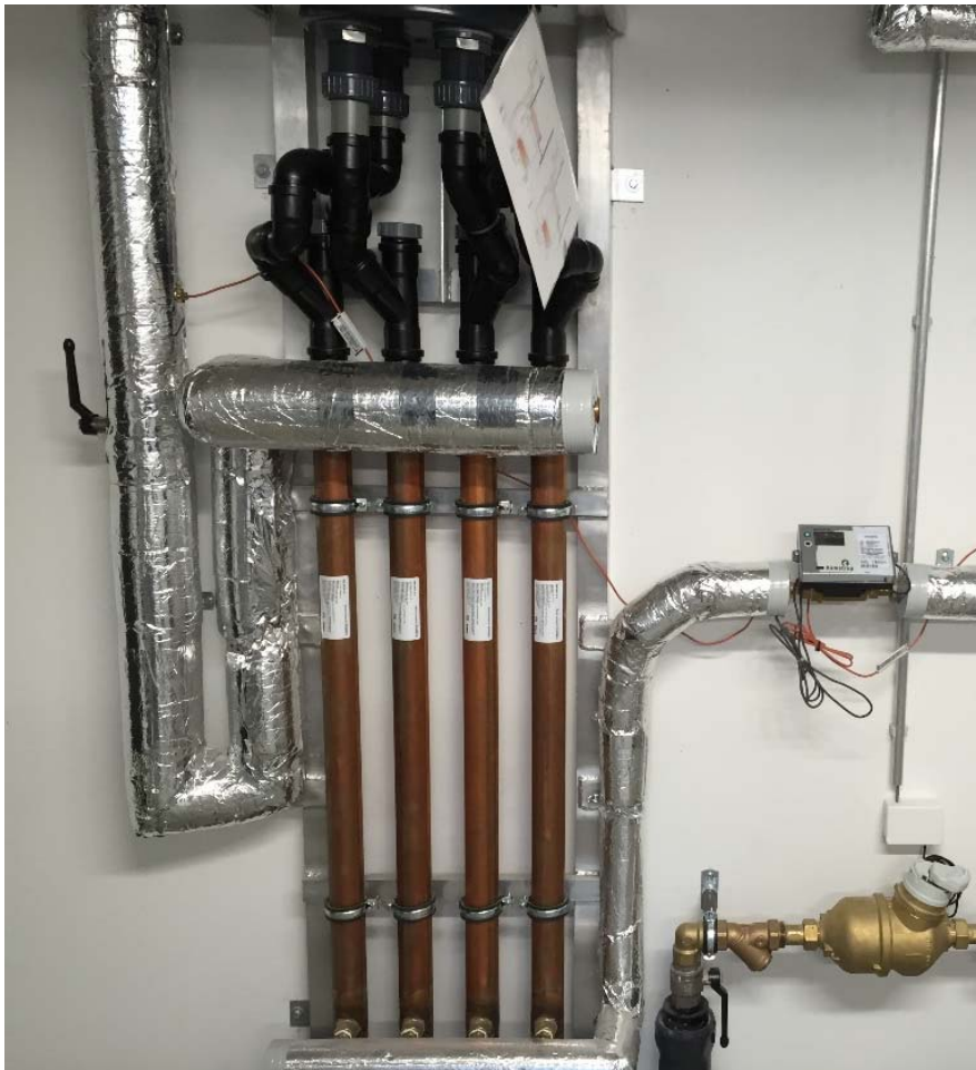
Figur 3.14 Varmegenvinding på det grå spildevand.
