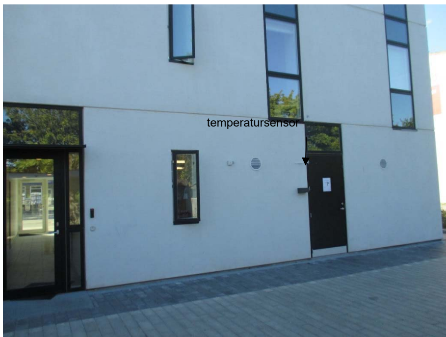
Figur 4.3 Placeringen af udeluft temperatursensoren.
