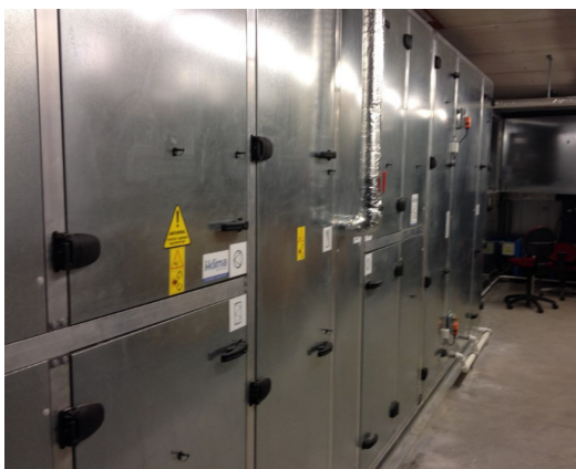
Figur 130 Centralaggregatet på 6. sal
