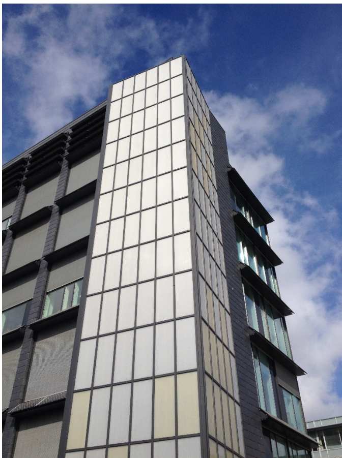
Figur 126 Solvæg på Kalkværksvej 10a. Aarhus
