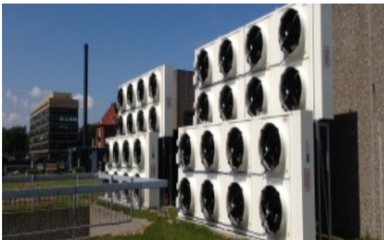
Figur 23 Tørkøler med horisontalt afkast
