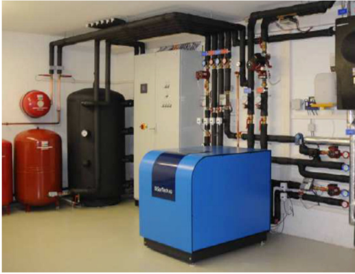
Figur 46. Anlæg med adsorptionskøler (SorTech/Fahrenheit)
