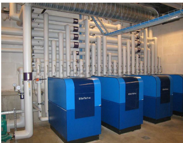
Figur 107 Adsorptionsvarmepumperne på Viborg Rådhus (COWI A/S)
