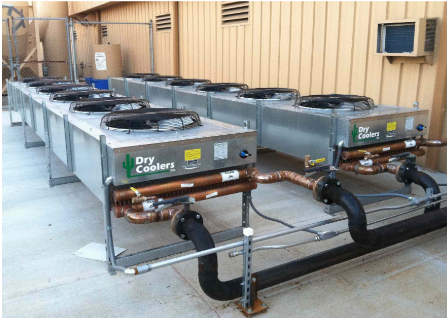
Figur 22 Tørkøler på ben, vertikalt afkast
