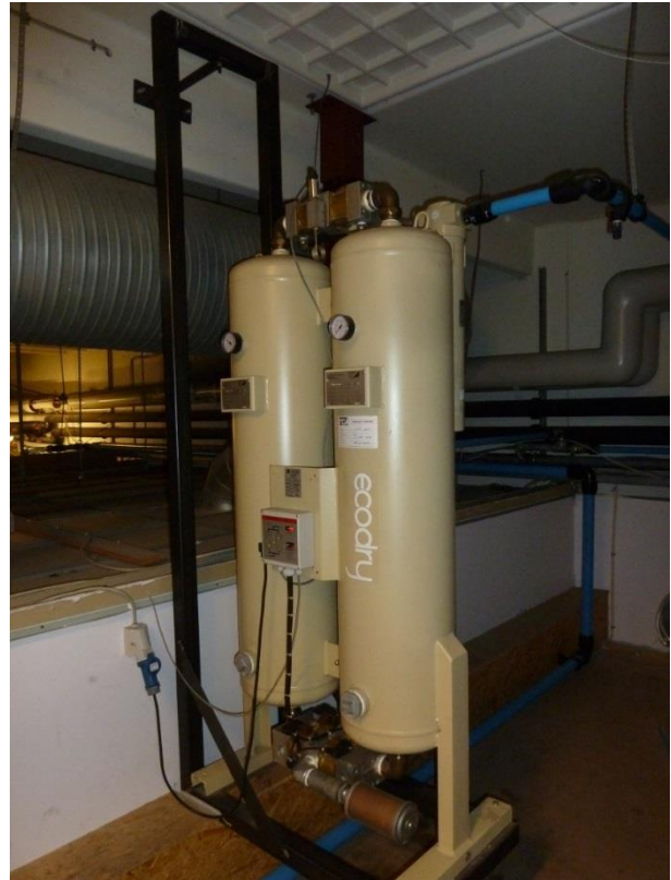
Figur 4.48 Adsorptionstørrer placeret ovenpå renrum.
