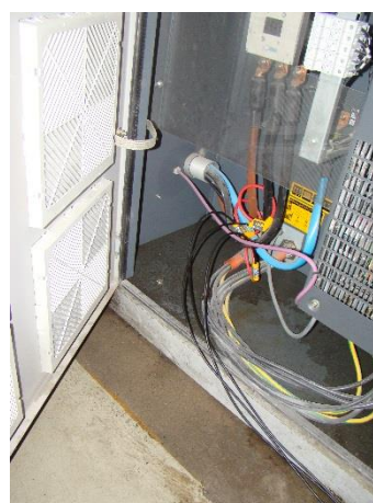
Figur 5.14. Måling af strøm i de tre faser
