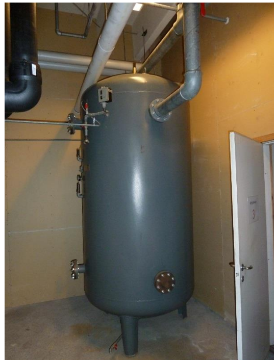
Figur 4.50 Beholder i kompressorum 3.
