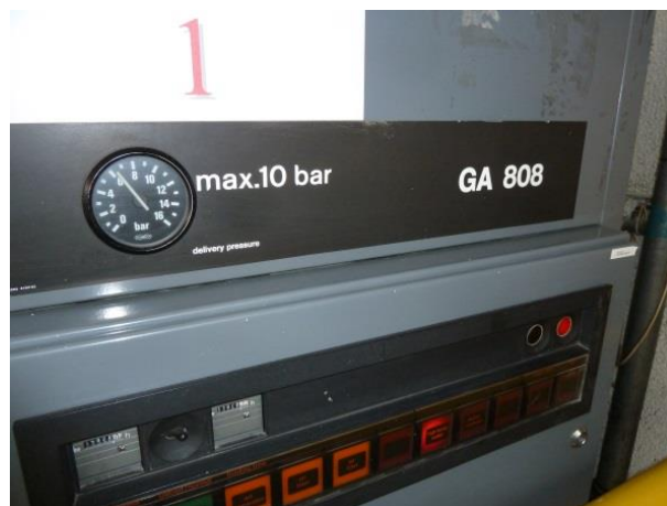
Figur 4.34 Kompressor 1 - styringspanel
