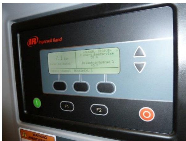
Figur 4.36 Kompressor 2 - styringspanel
