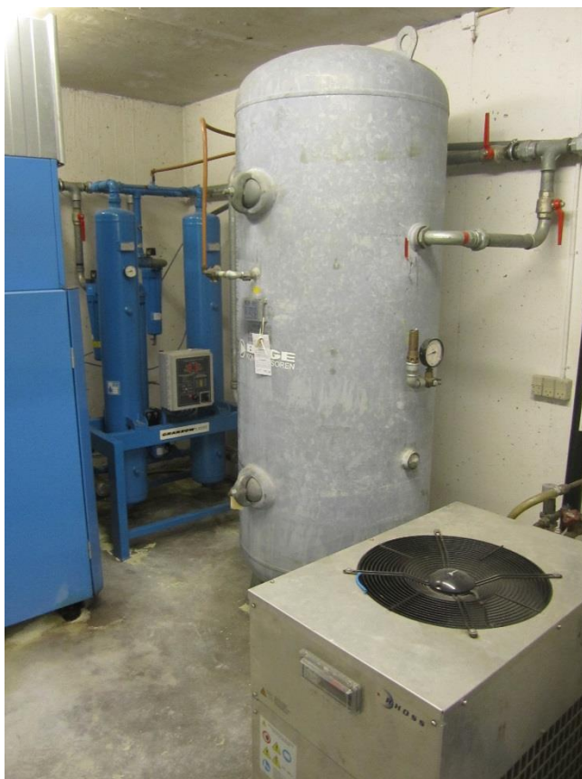
Figur 5.67 Tryklufttank
