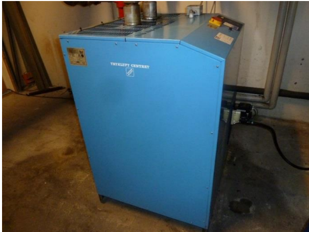
Figur 4.47 Køletørrer i kompressorum 3.
