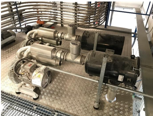
Figur 3.1 Centralt vakuumsystem
