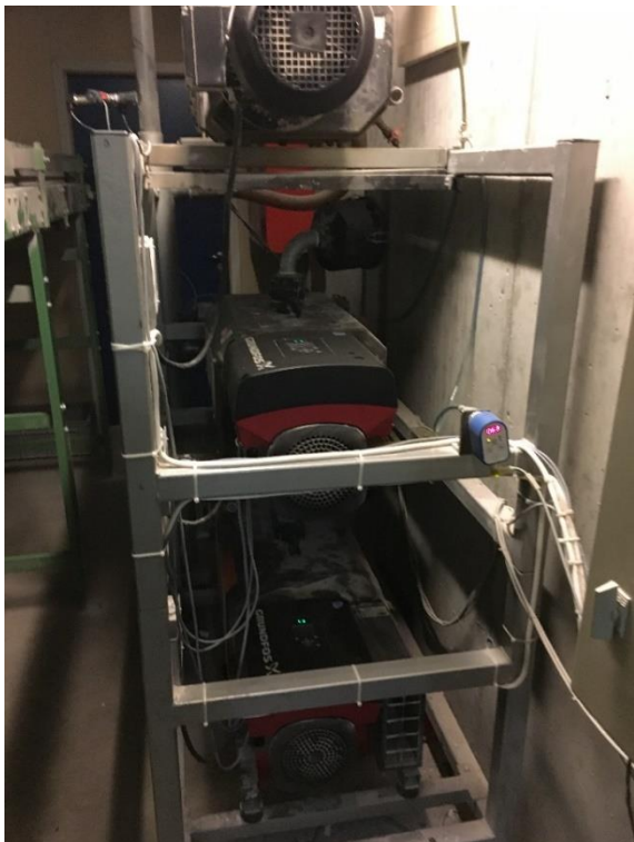
Figur 5.5 Omdrejningstalsregulerbare vakuumpumper
