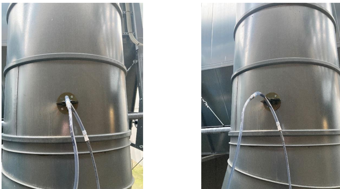
Figur 9.3.6 Rotation af pitotrør efter 6 ugers drift.
