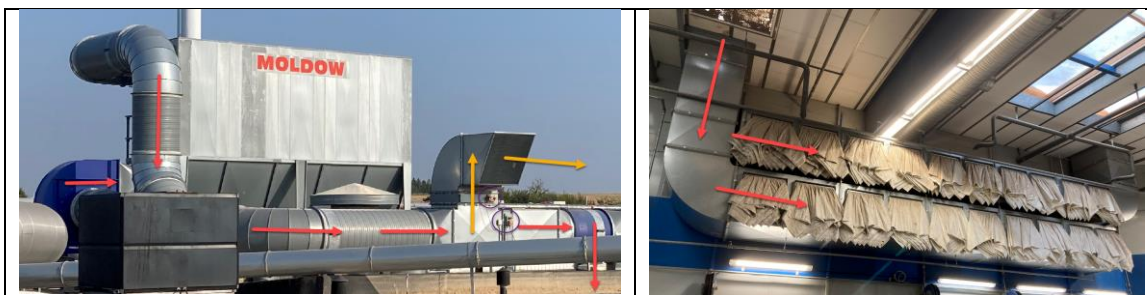
Figur 9.4.9 Recirkuleringsarrangement hos DS Smith.
