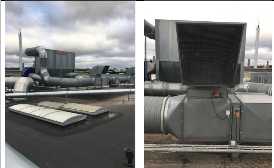
Figur 9.4.7 Recirkuleringsarrangement hos DS Smith.
