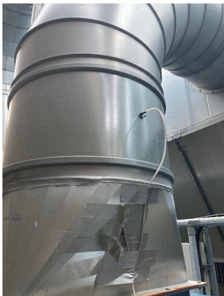
Figur 9.3.2 Montering af trykstuds til differenstryk målinger.
