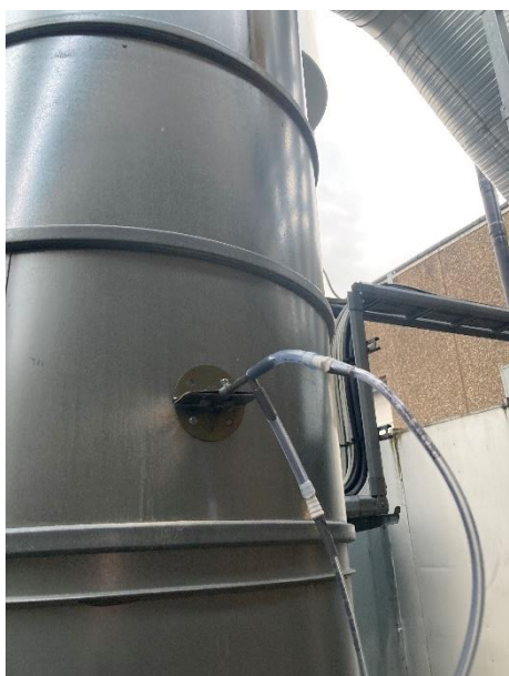
Figur 9.3.3 Montering af pitotrør på udsugningskanal.
