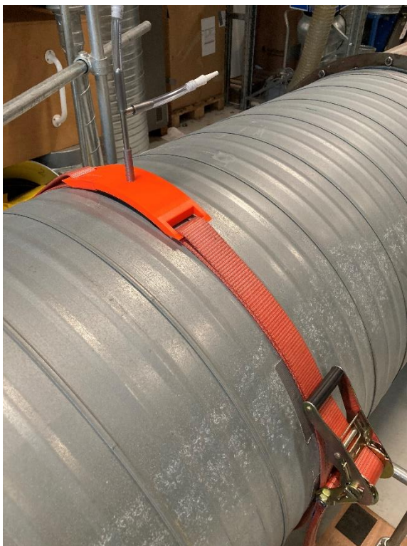
Figur 9.2.10 Test af 3D-printet monteringsplade på ventilationskanal.
