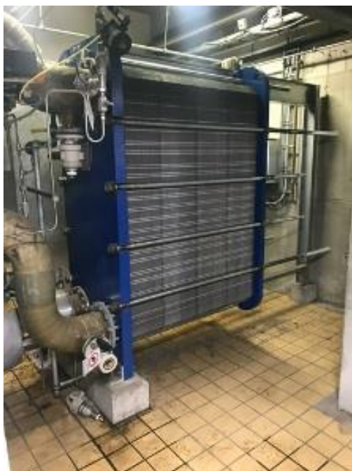
Figur 4: FoulingCure montage på bagsiden af pladevarmeveksler.
