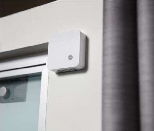
Som led i ELFORSK-projektet 'Dynamisk kontormiljø på brugerens præmisser' er der opsat sensorer, der måler temperatur og bevægelse hos Implement Consulting Group.
