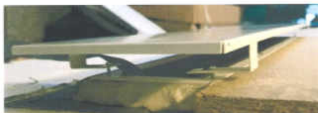
Figur 3 Monteret afdækningskærm uden lydabsorbent, placeret på indvendig side af MicroVent. Foto drejet 90 grader.
