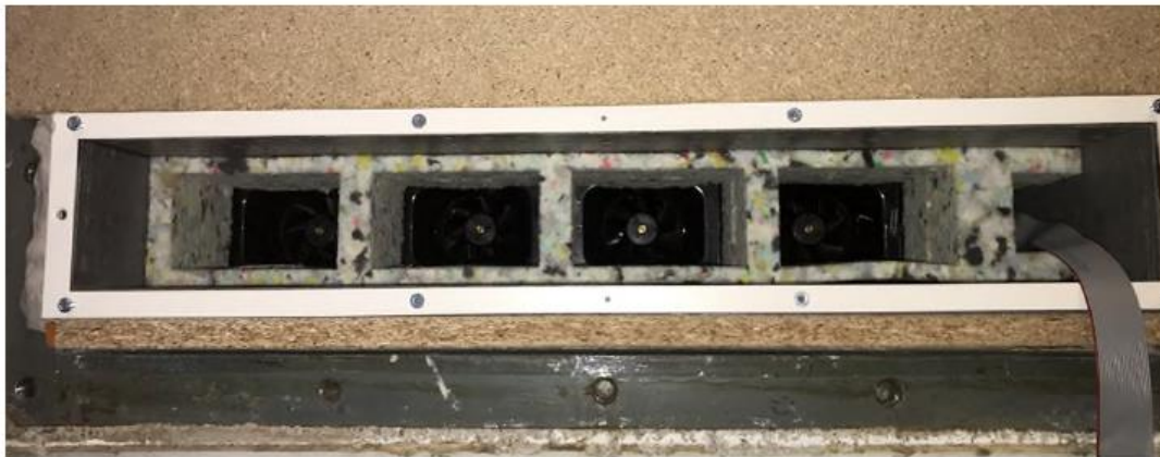
Figur 2 MicroVent enhed monteret i åbning, afdækningsskærm fjernet, og først halvdel af 'lydabsorberende' materiale fjernet (= lydfælde i kanaler). Blæserne kan ses i hver kanal.
